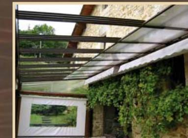
Vista interior de techo móvil abierto con una apertura del 66%, con una hoja fija, dos móviles y accionamiento manual. Previsto con una guía inferior para la colocación de toldos planos.
