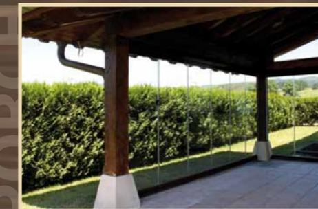
Porche de **MADEIRA LUXOR** de una portería con cierre perimetral con cortina de cristal templado de 10 mm. Cubierta con teja.
