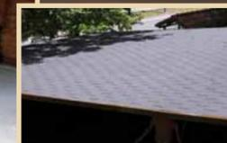
Tégola. Tela asfáltica de superficie autoprotectida con gránulos minerales coloreados.
