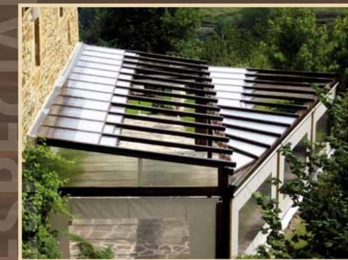
Estructura de **MADEIRA LUXOR** con techo móvil de policarbonato celular de 16 mm con tratamiento UVA a dos caras y a dos niveles de altura. Cierre perimetral con toldos verticales
